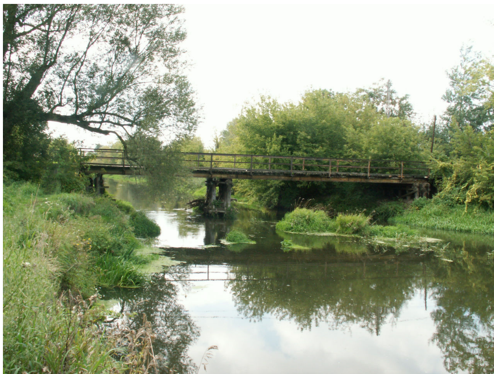
Widok na most w górę rzeki Bzury
